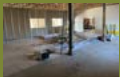
TRAVAUX RÉALISÉS À WISCHES
